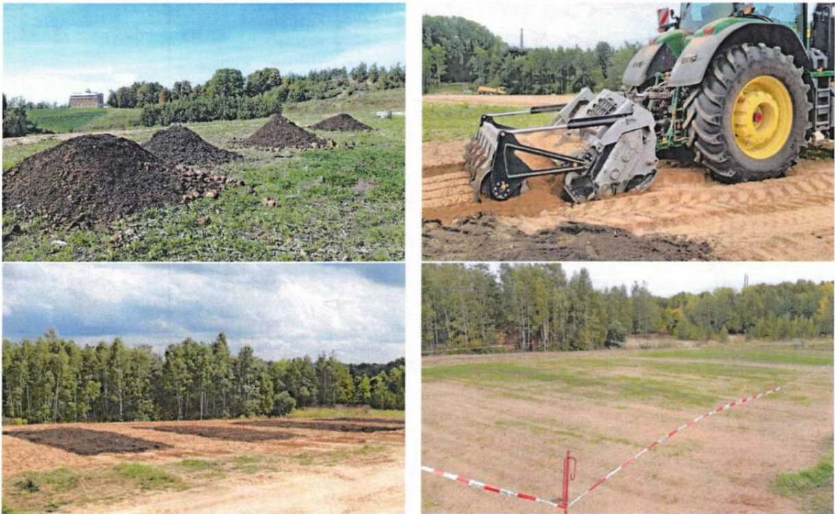
Abbildung 19: Einbau der Rekultivierungsmaterialien auf der Spülhalde Hammerberg am 13.09.2023, Haufwerke mit den Substratmischungen (links oben), Einarbeitung mit der Forstfräse (rechts oben), Versuchsfelder mit den verteilten Substratmischungen (links unten) und Versuchsfläche am 24.10.2023 (rechts unten).
