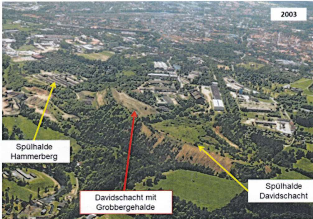
Abbildung 8: Davidschachtkomplex vor der Sanierung.
