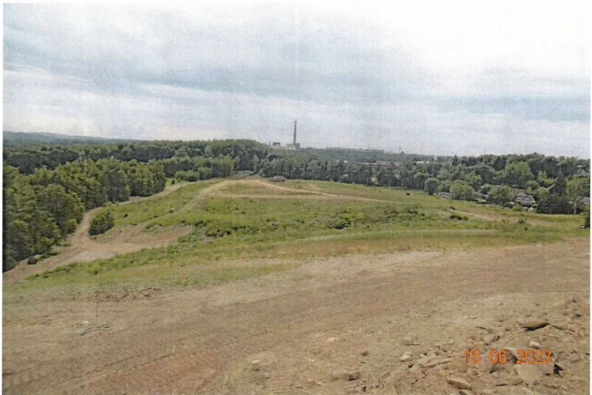
Abbildung 13: Das fast fertiggestellte Plateau der Spülhalde Hammerberg.
