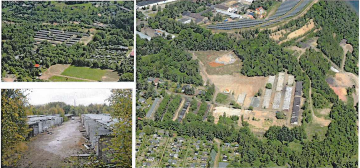
Abbildung 12: Spülhalde Hammerberg mit Garagenkomplex vor der Sanierung (links) und sanierungsvorbereitende Maßnahmen (rechts).
