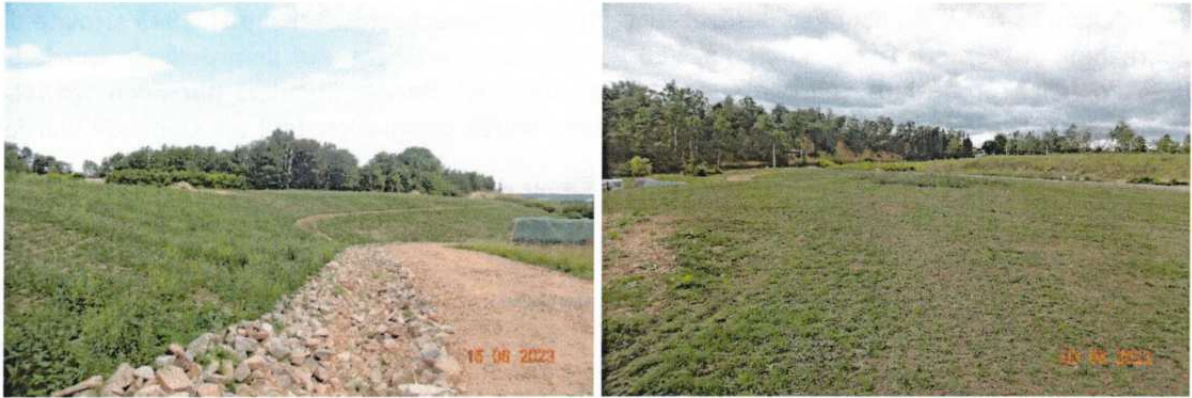
Abbildung 15: Sanierte Altdeponie Porzellanwerkshalde mit Erstbegrünung (links) und nach der Mahd (rechts).
